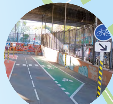
Rénovation du Plateau Sportif Kléber
